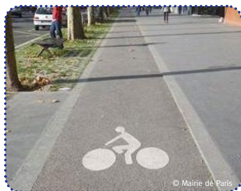
Avenue de la Porte d'Ivry (13 e ) : le revêtement de la piste cyclable laisse la pluie s'infiltrer dans le sol, les pavés entre les arbres aussi, tout en accueillant de l'herbe.
