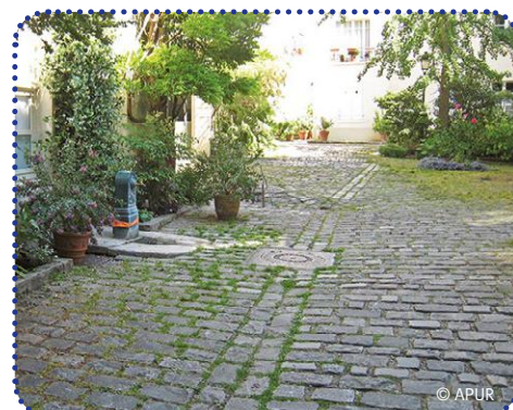
Paris 4 e : les pieds d'immeubles sont plantés, des joints perméables favorisent l'infiltration de la pluie entre les pavés de la cour.
